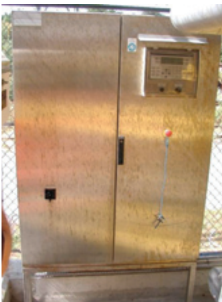
Afbeelding 8: vliegroeft op een schakelkast van 316 vanwege aerosolen uit de zee.
