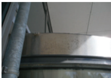
Afbeelding 3: detail van foto 2 waarin men de aantasting door aerosolen kan zien.
