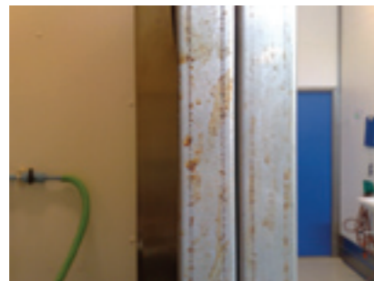
Afbeelding 9. (links) RVS 316-deurstijl aangetast door zoutzuurdampen.
