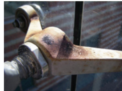
Afbeelding 3. Door aerosolen zwaar aangetast roestvaststaal gietwerk
